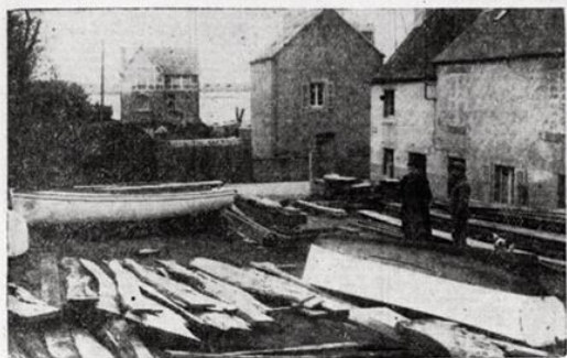
Sur les chantiers Mével (Photo-cliché « Ouest-France »).
